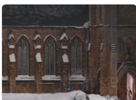
Архитектурные обмеры и обследования
